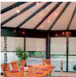
Paneles aislantes en techo y persianas integradas en la fachada
