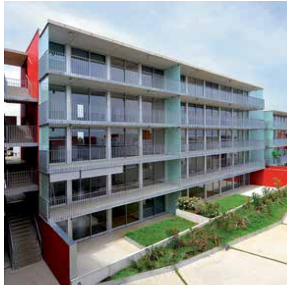
Arquitecto: Puig Pujol - Fotografía: B. Hanne
